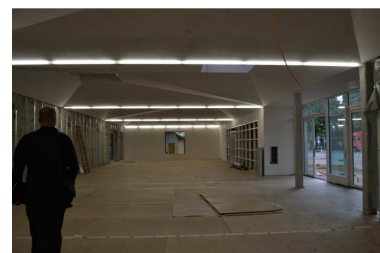
Neubau Quartiershalle, Eingangsbereich
